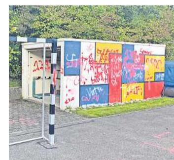
Übel zugerichtet: Unter den Schmierereien sind auch Hakenkreuze zu sehen. Bild: zvg
